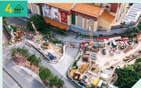
4 於香港文化博物館附近進行鑽孔樁工程，以建造高架橋 Bored piling works near the Hong Kong Heritage Museum for the construction of viaduct
